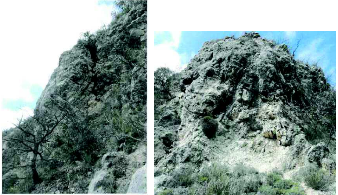
Illustration n°4 : vues du bloc rive gauche – Instabilité 1
