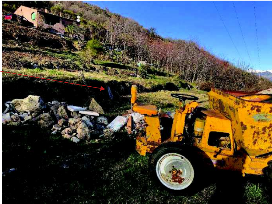
Photo n°7 : canal en zone E du lotissement le Colombier Photo du 25 janvier 2021
