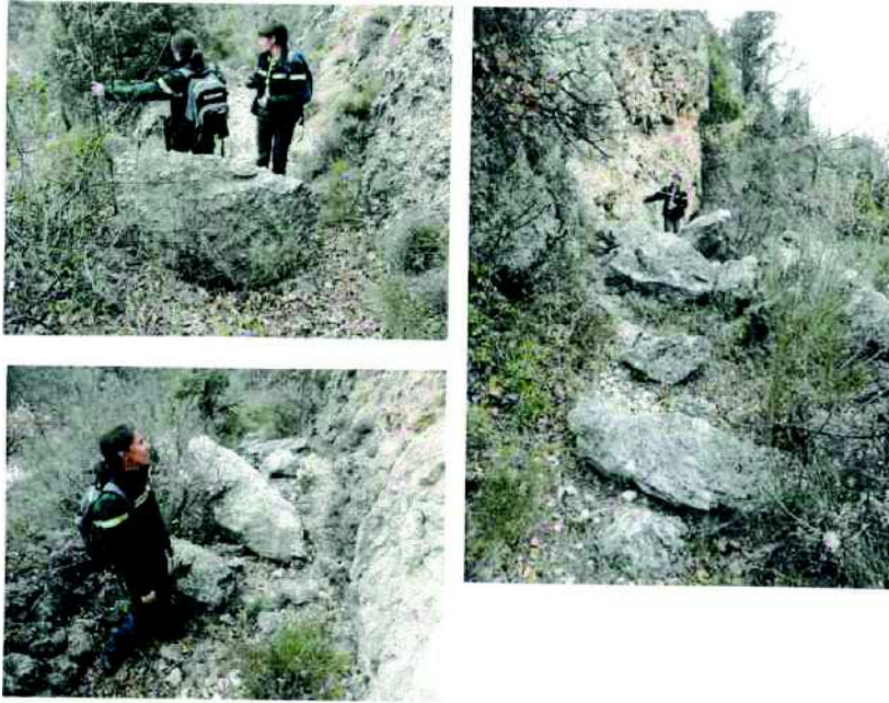
Exemples de blocs descendus sur la zone à enjeux - secteur D
