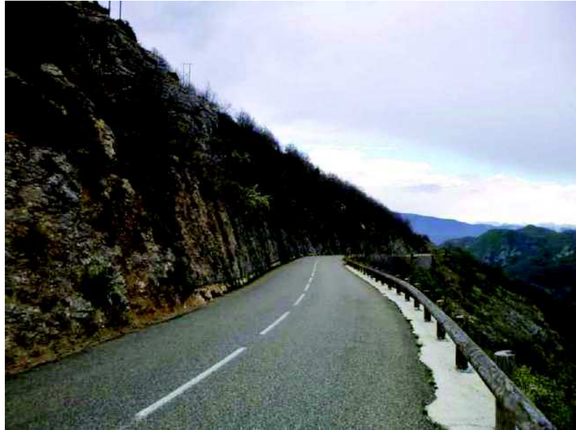
Photo n°94 : protection grillagée le long de la D8 à l'ouest du village de Bouyon
