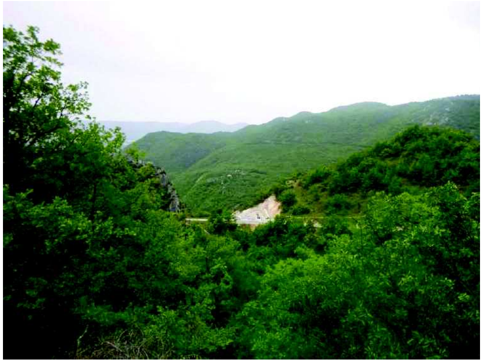
Photo n°97 : vue de la STEP du village depuis le nord-ouest (D1) Photo du 10 juin 2019
