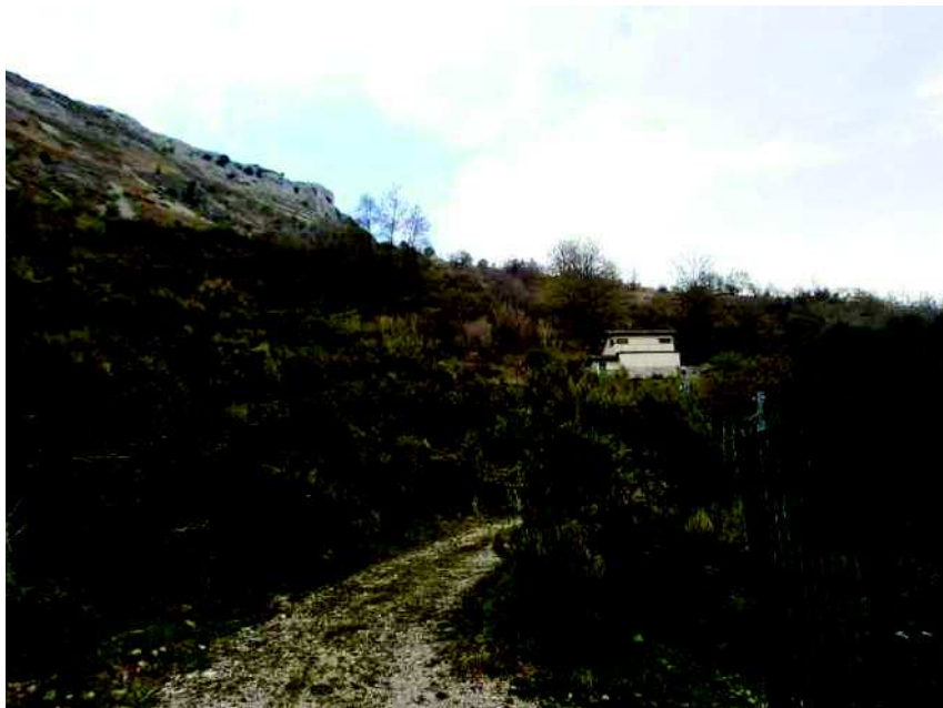
Photo n°100 : vue du bâtiment technique exposé aux chutes de blocs en amont de l'usine de traitement des eaux - Photo du 10 avril 2019
