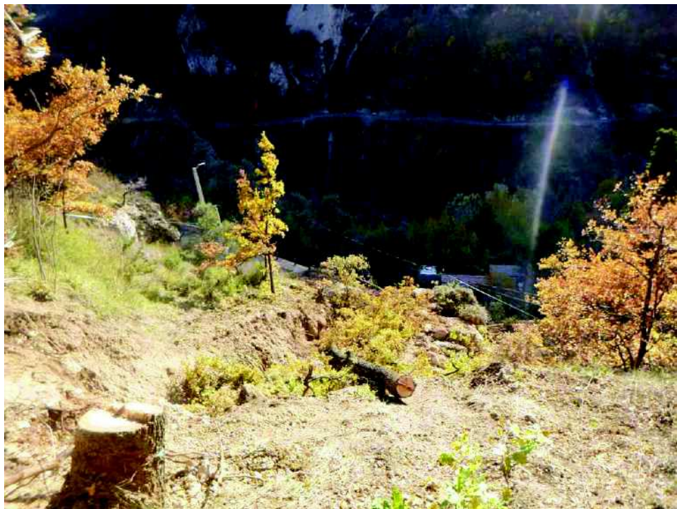
Photo n° 45 : vue du corps du glissement survenu le 24 novembre 2019 Maison en aval
