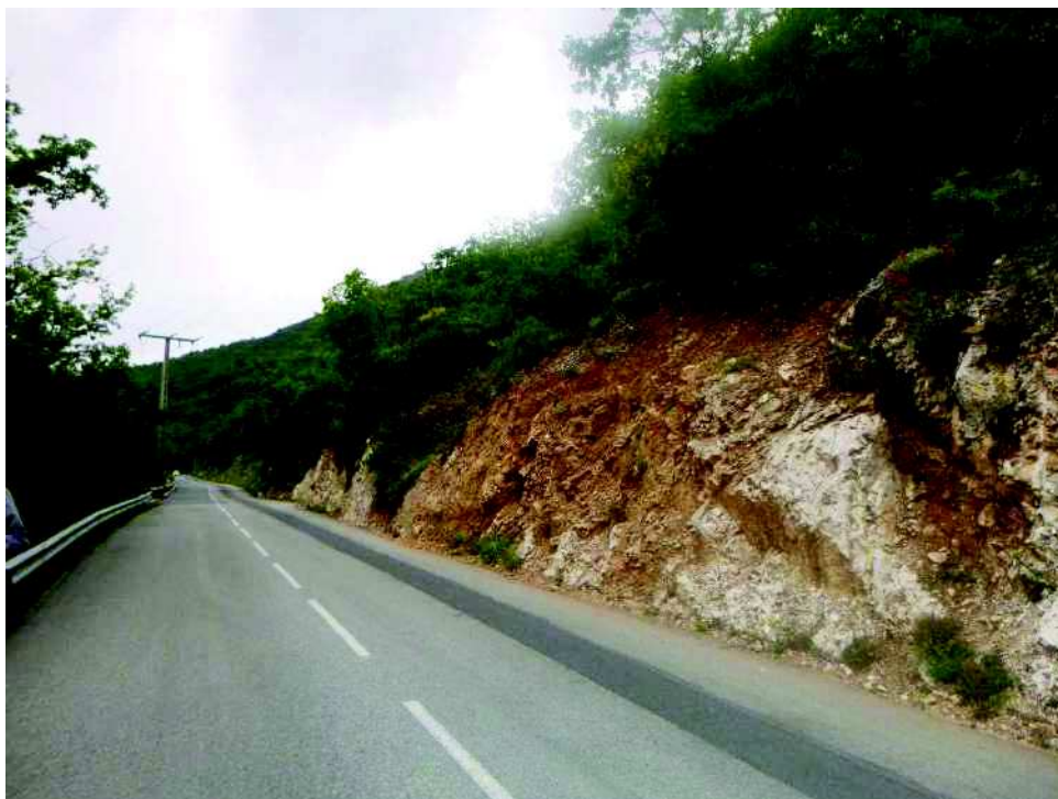
Illustration n°13 : affleurement de calcaires et dolomies du Kiméridgien en partie broyés et mêlés à des éboulis en bordure de la D1 en direction des Ferres Photo du 10 juin 2019
