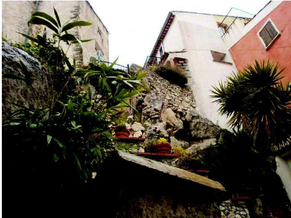
Photo n°73 : construction d'un mur sur des blocs instables en partie sud-est du village - Photo du 10 avril 2019
