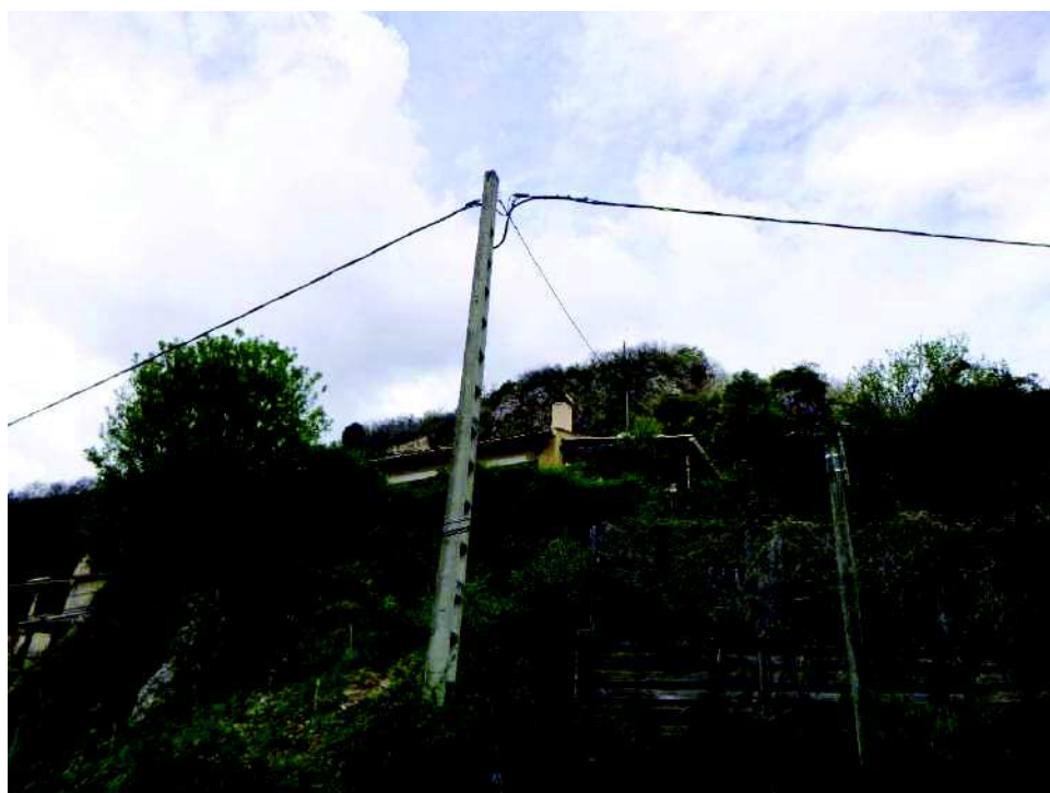
Illustration n° 19 : éboulis plus ou moins consolidé en amont des maisons Quartier des Moulins – Photo du 10 avril 2019
