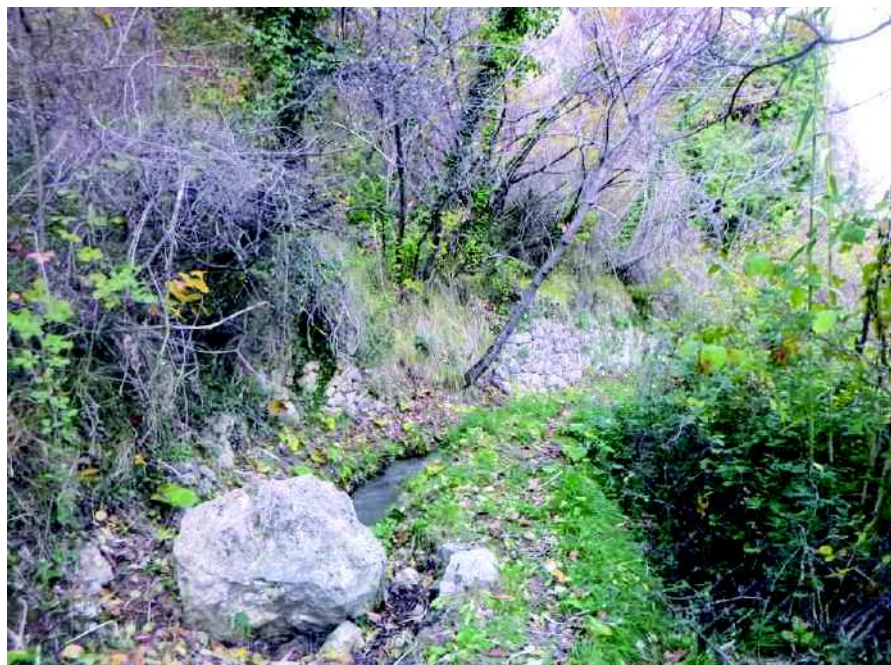
Photo n°63 : bloc obstruant le canal des Moulins Photo du 30 novembre 2019
