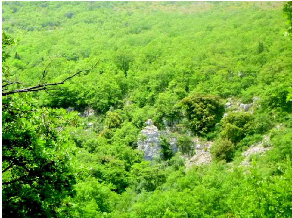
Photo n°76 : pinacle pouvant générer des blocs au-dessus de la D1 à la sortie du village en direction des Ferres – Photo du 10 juin 2019
