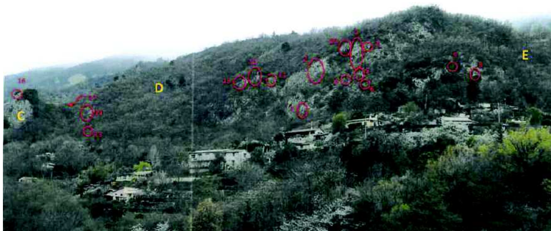
Illustration n°7 : vue générale des instabilités recensées
