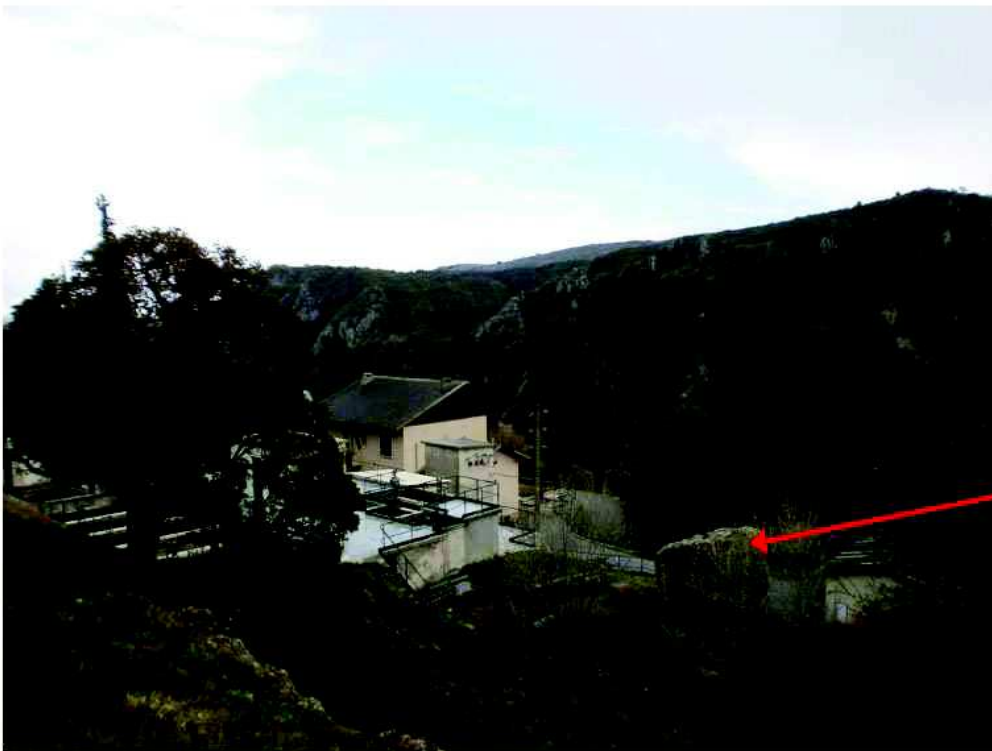
Photo n° 66 : bloc arrêté dans le périmètre de l'usine des Eaux Photo du 12 avril 2019
