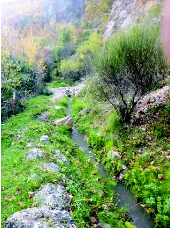
Photo n°62 : blocs tombés en bordure du canal des Moulins Photo du 30 novembre 2019
