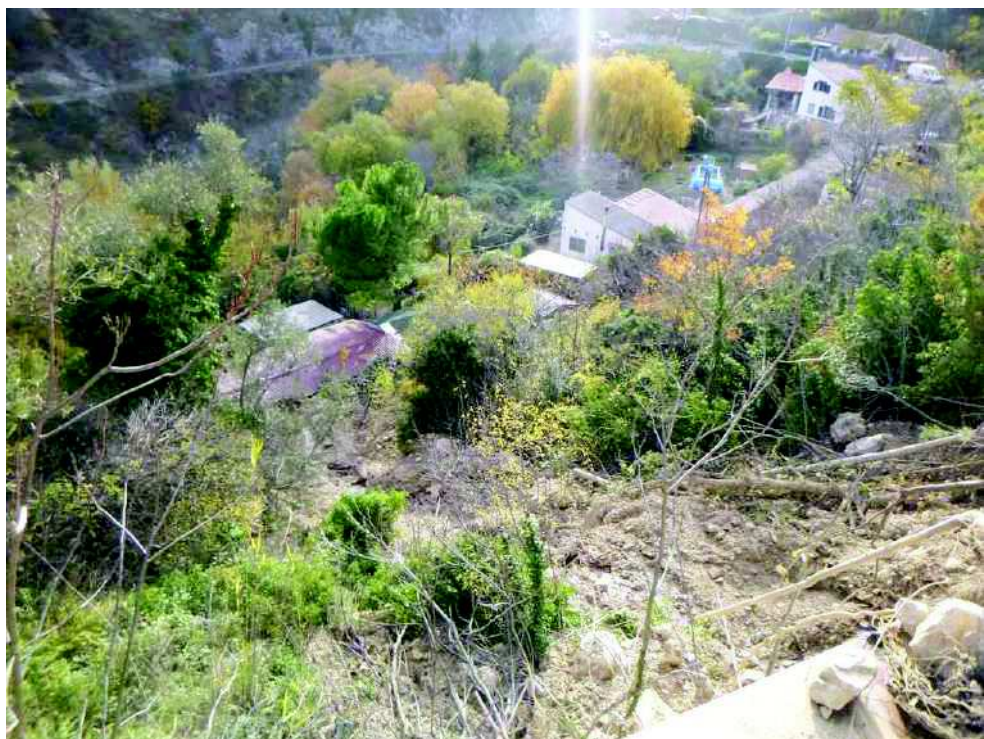
Photo n° 49 : vue de la partie aval de la D1 à la suite du glissement survenu le 24 novembre 2019
