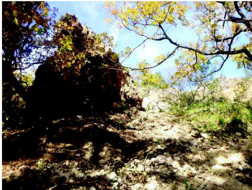
Photo n° 44 : bloc instable immédiatement au-dessus de la tête de glissement du 24/11/19 - Quartier les Moulins en amont de la D1
