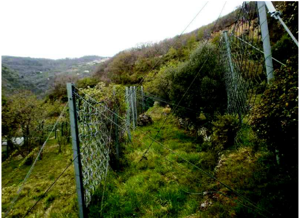
Photo n°67 : écrans pare blocs en amont de l'usine des Eaux Bloc arrêté contre le grillage
