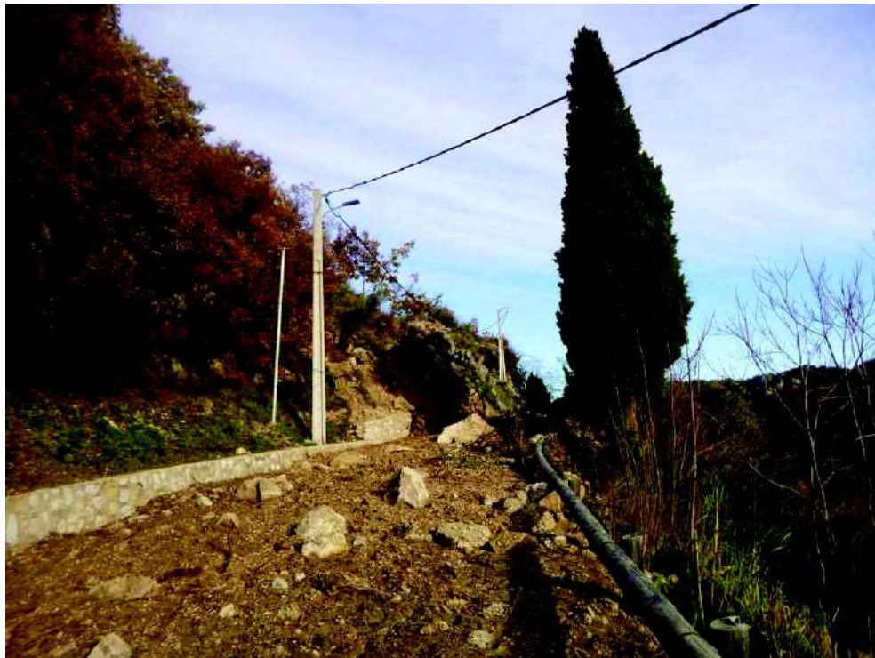
Photo n° 48 : état de la D1 en pied du pied du glissement survenu le 24 novembre 2019
