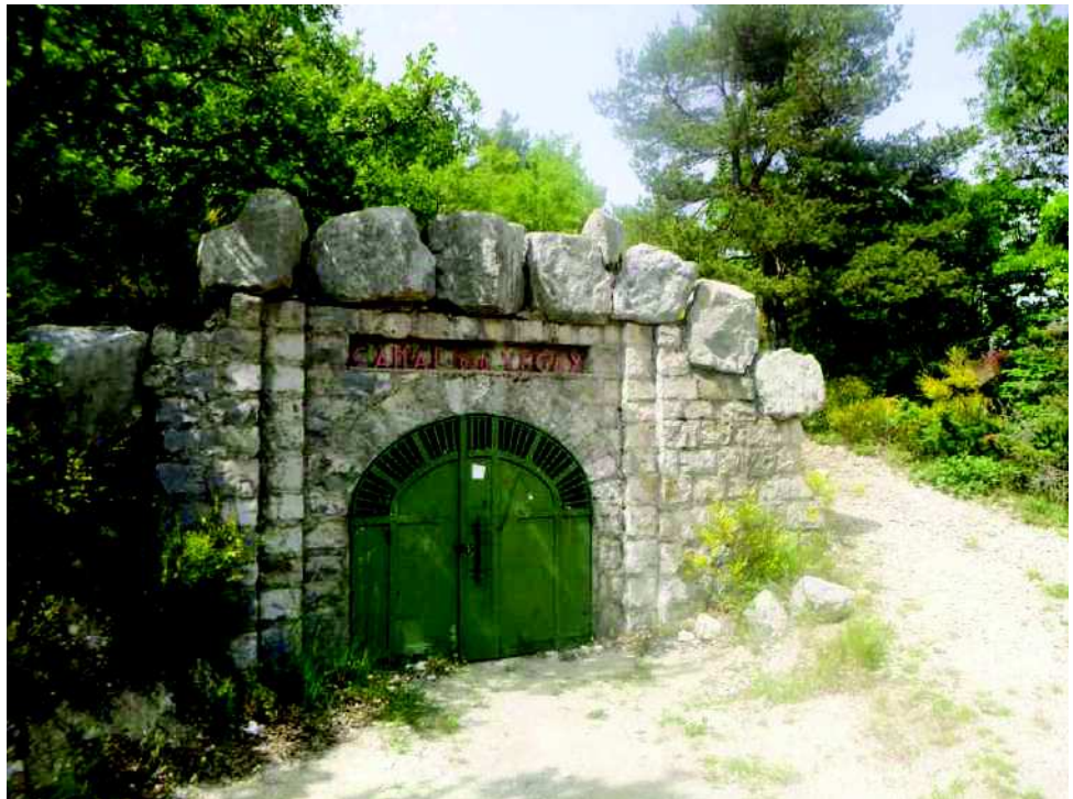
Photo n°96 : Chambre sur le parcours du canal de Végay à Bouyon Photo du 10 avril 2019
