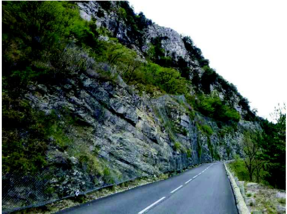
Photo n°90 : protection grillagée le long de la D1 Quartier la Mouchonnière – Photo du 10 avril 2019
