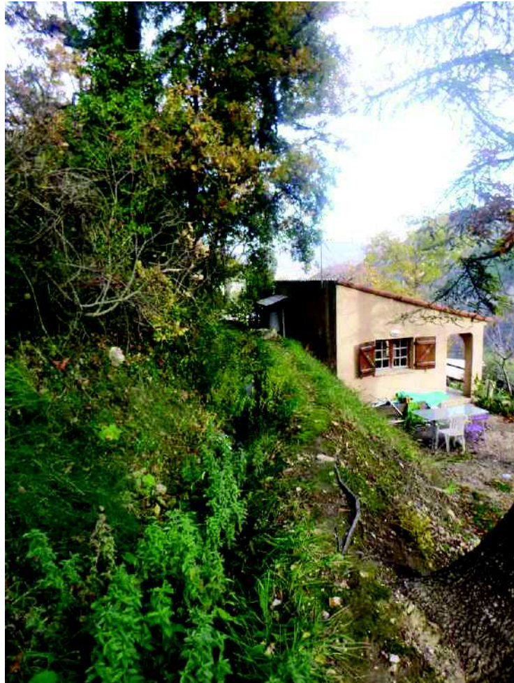
Photo n°98 : bâtiment exposé aux chutes de blocs – Quartier des Moulins Photo du 30 novembre 2019
